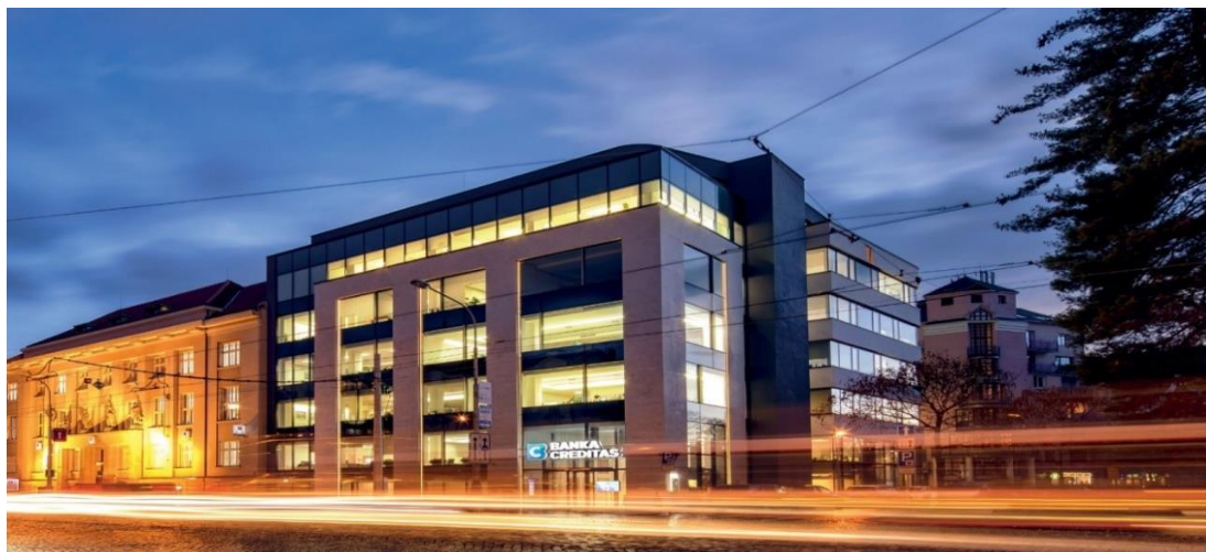
Administrativní budova v Olomouci
