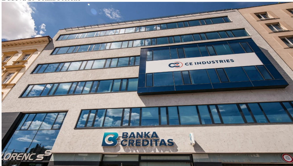
Budova S9 Praha Florenc
